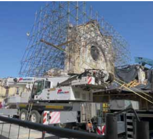
Die Renovierung der Kirche des hl. Benedikt beginnt.
